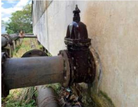
**Figura 3 – Vazamento no registro**
